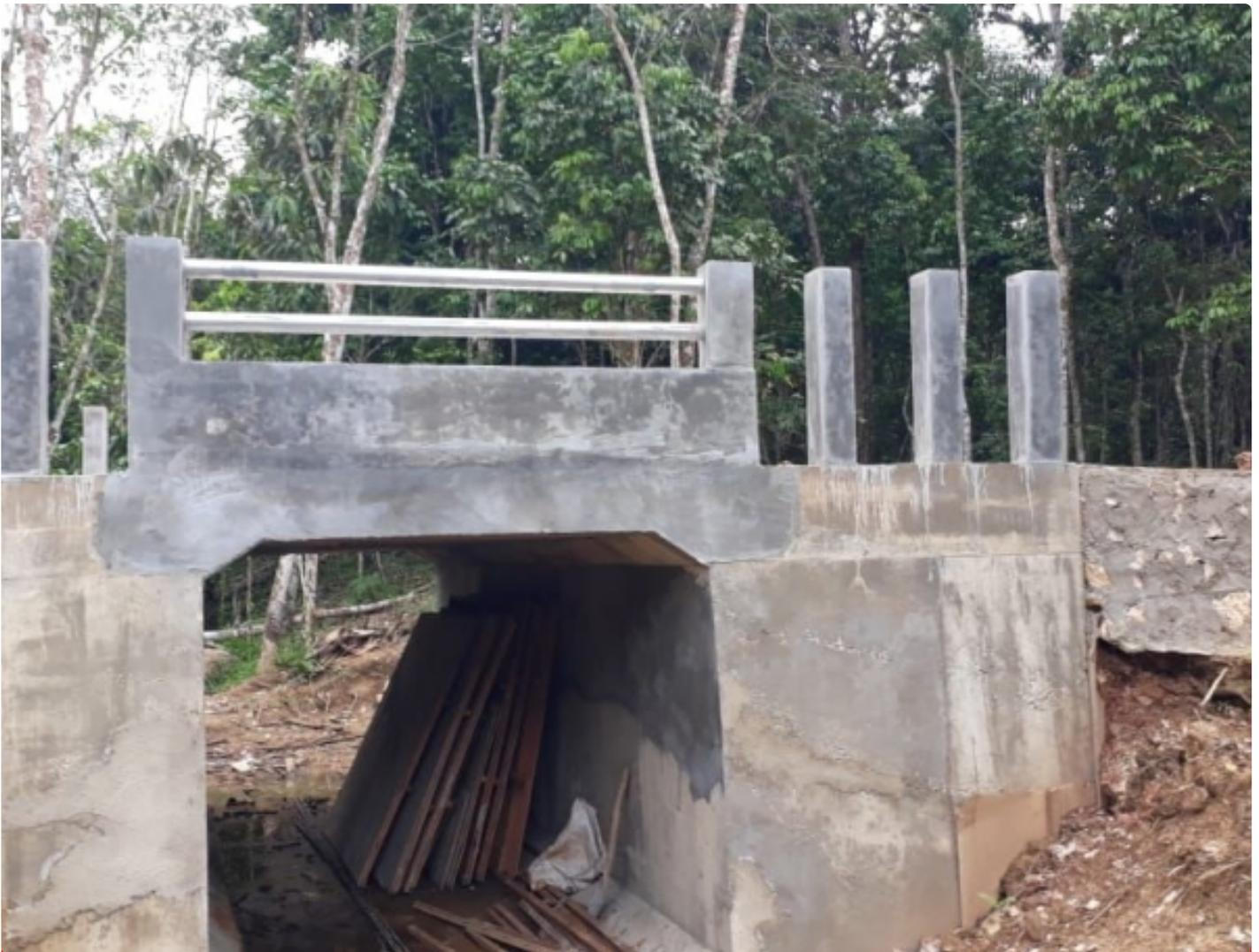
*Jembatan Box Culvert Masuk Tahap Finishing*
