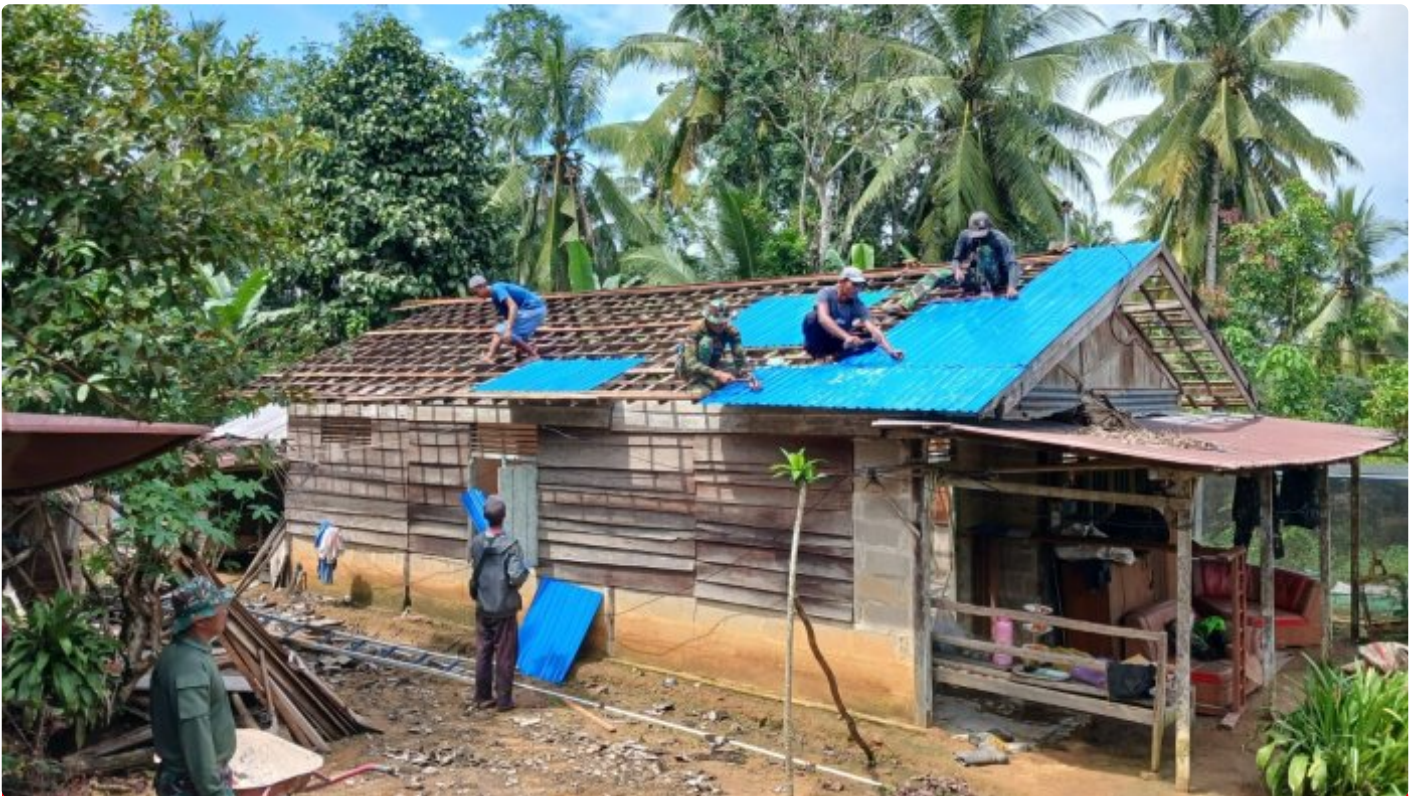
Kodim 1008/Tabalong Laksanakan Rehab RTLH, Warga Mengaku Senang dan Bersyukur
