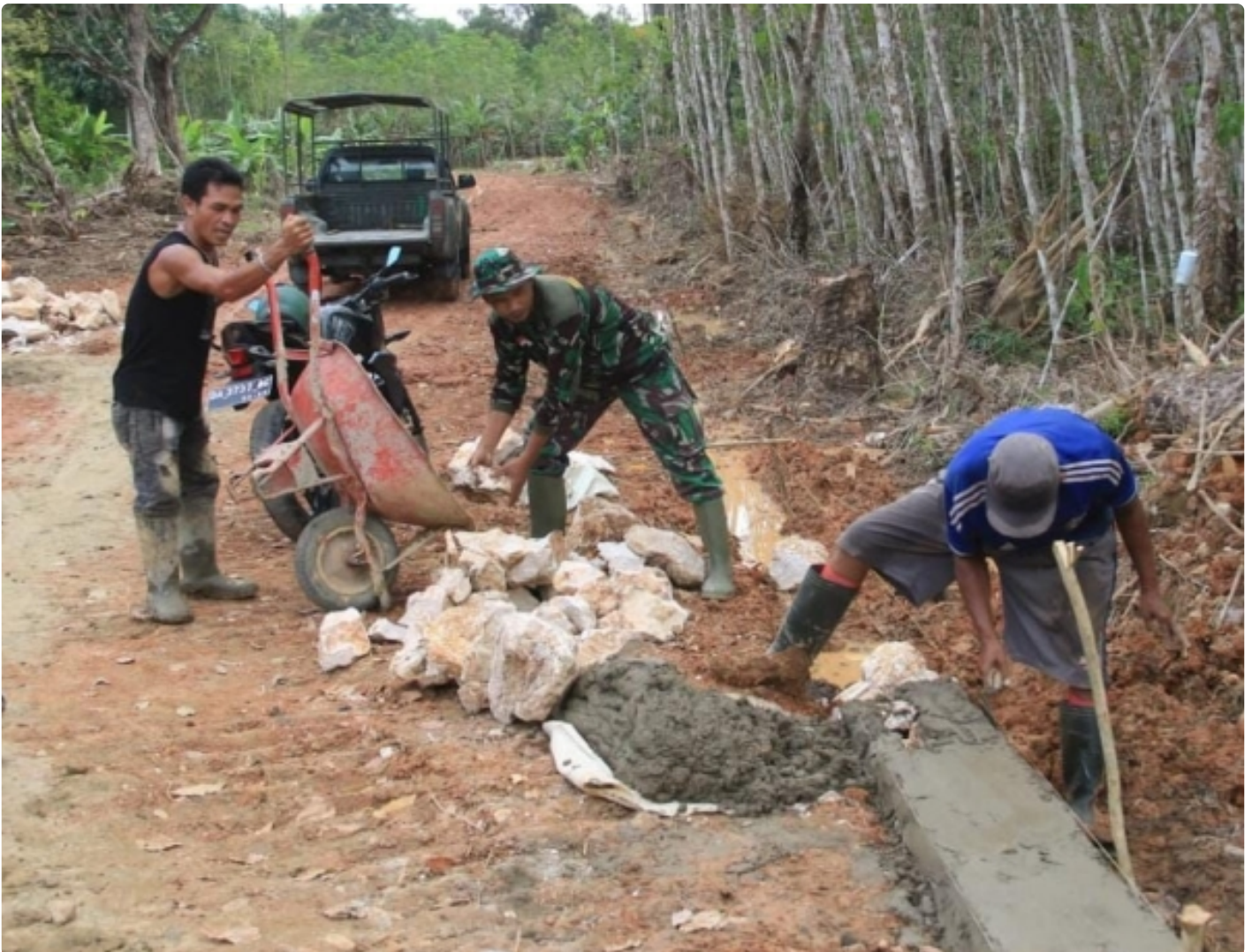
Pembuatan Badan Jalan Sepanjang 1020 meter Capai 45 Persen
